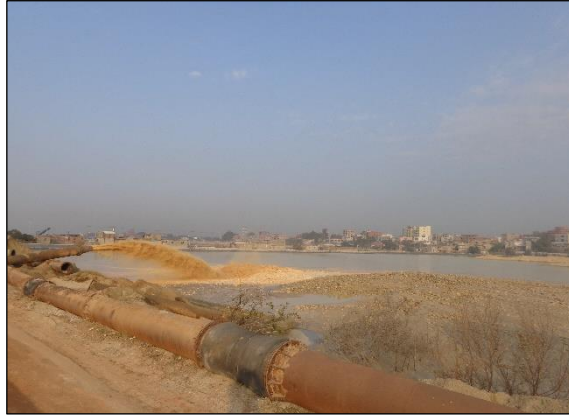
图 4.1-1 疏浚物通过输泥管送到吹填区
