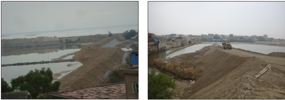
图 4.1-2 施工场地设置围堰
