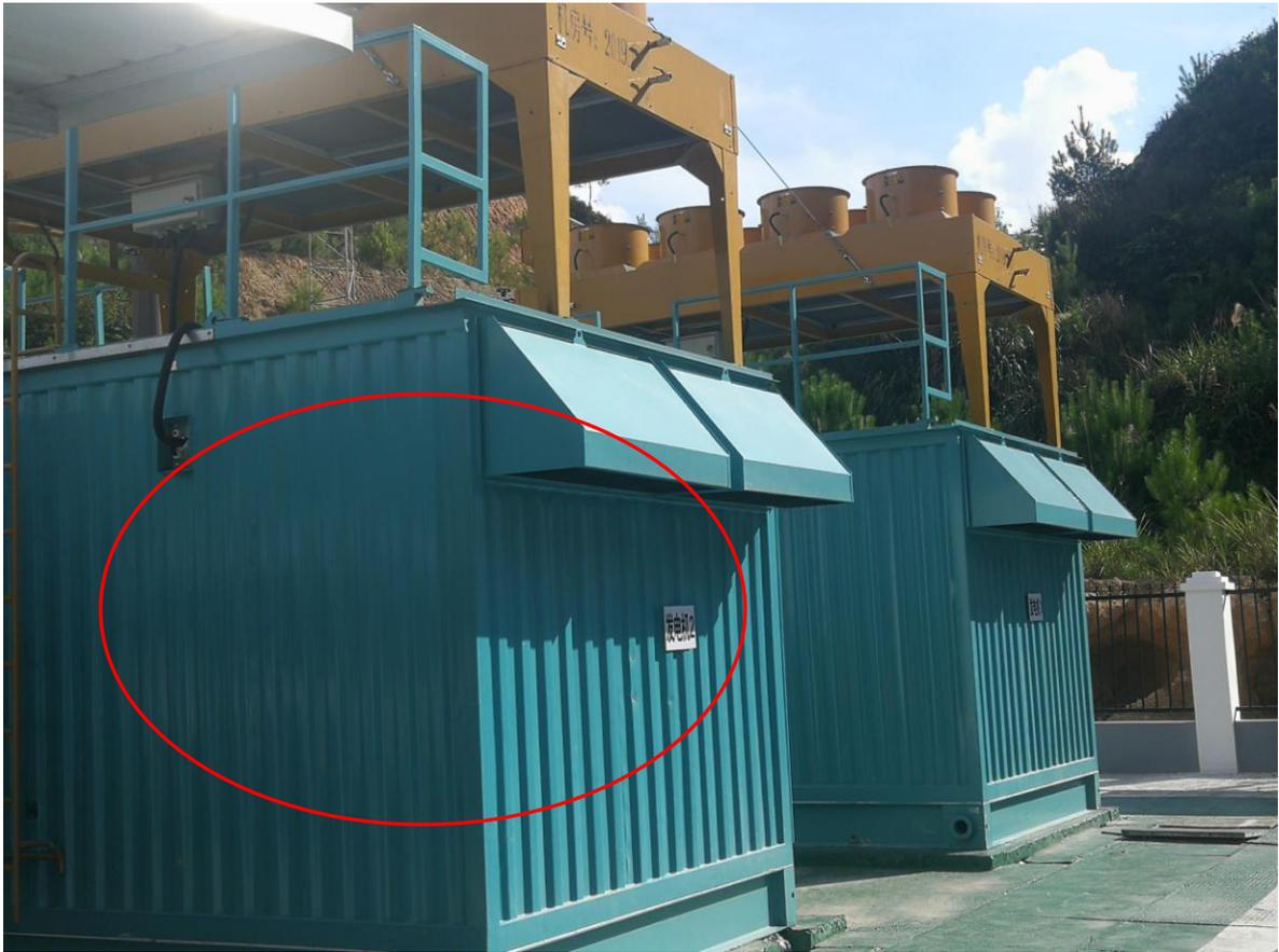
图 4-3 发电机组位于封闭的机房内
