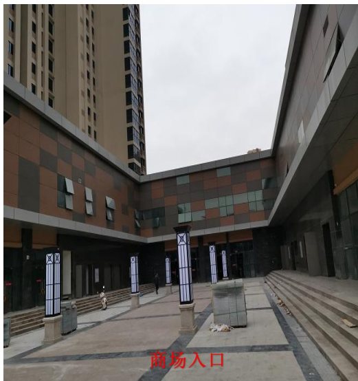
附图 4 项目建设现状图
