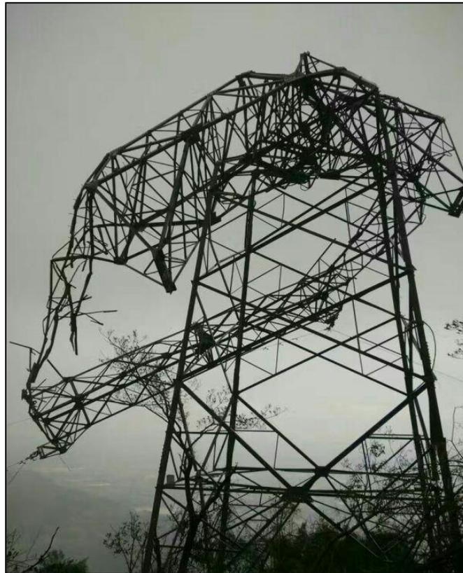
图 1.1-6 2016 年台风“莫兰蒂”过境厦门后高压电塔倒塌
