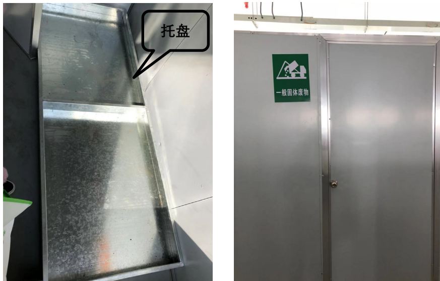
图 4-3 固体废物污染防治措施照片
