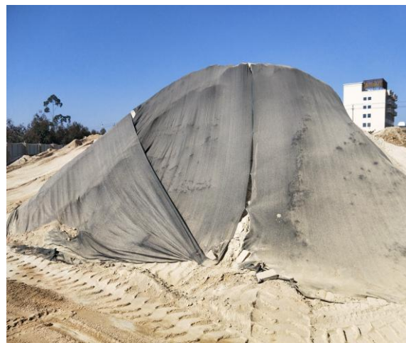
堆场防尘网覆盖
