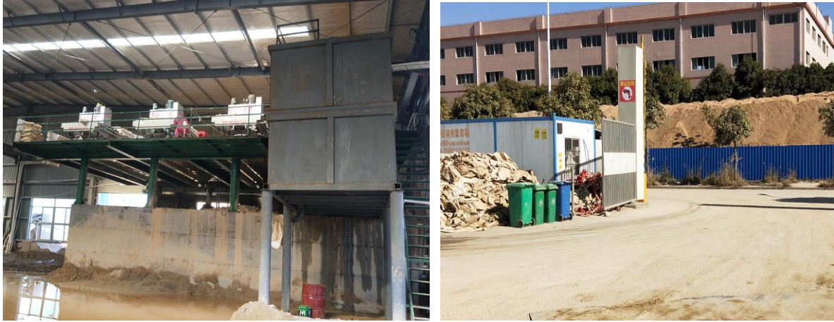
沉淀泥渣暂存处
