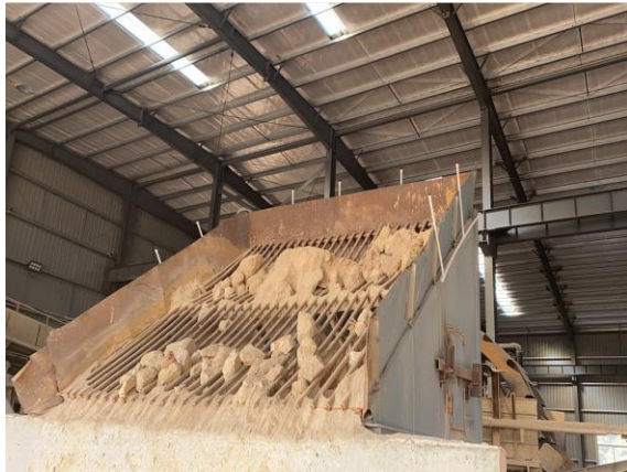
车间喷淋设施
