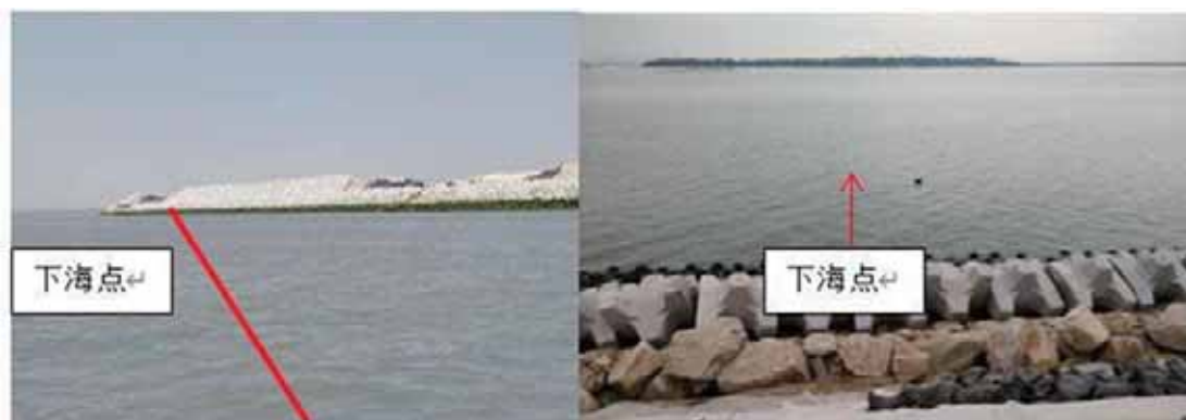
图 2.3-2 在建斜坡式结构的挡浪堤现状图
