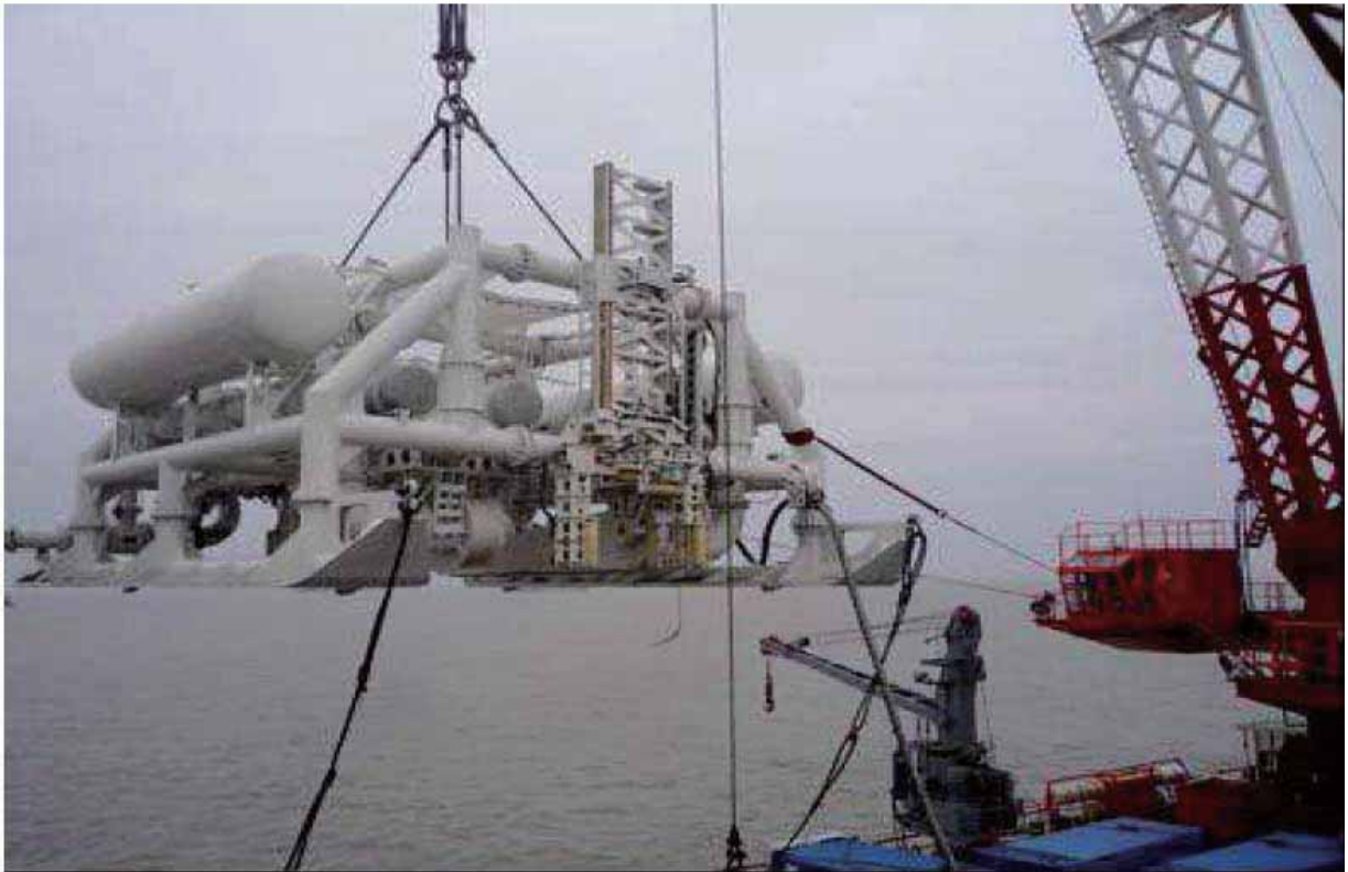
图2.3-5 后挖沟机现场作业图
