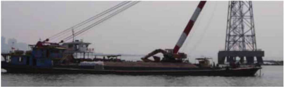
图 2.3-6 常见回填现场作业图
