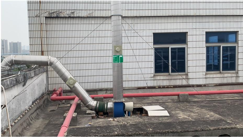
图 4-3 废气污染防治措施照片
