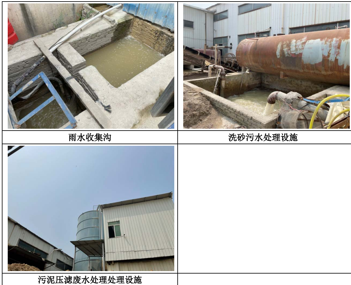
图 4.1-2 废水处理设施照片
