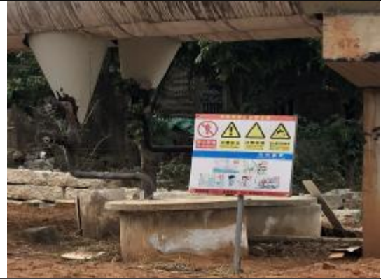
图片 6 冷凝水收集、警示牌
