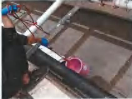
生活污水排放口
