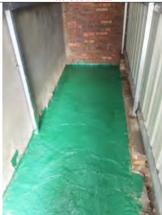
危险废物暂存间（内）
