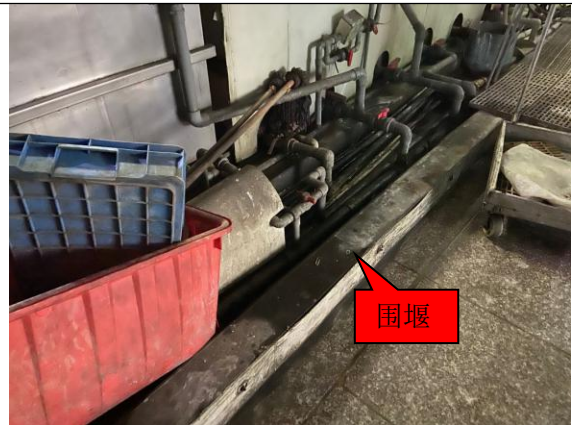
电镀生产车间围堰局部图
