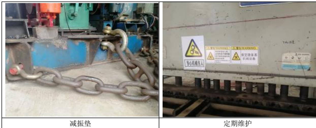
图 4-4 噪声防治措施现状照片
