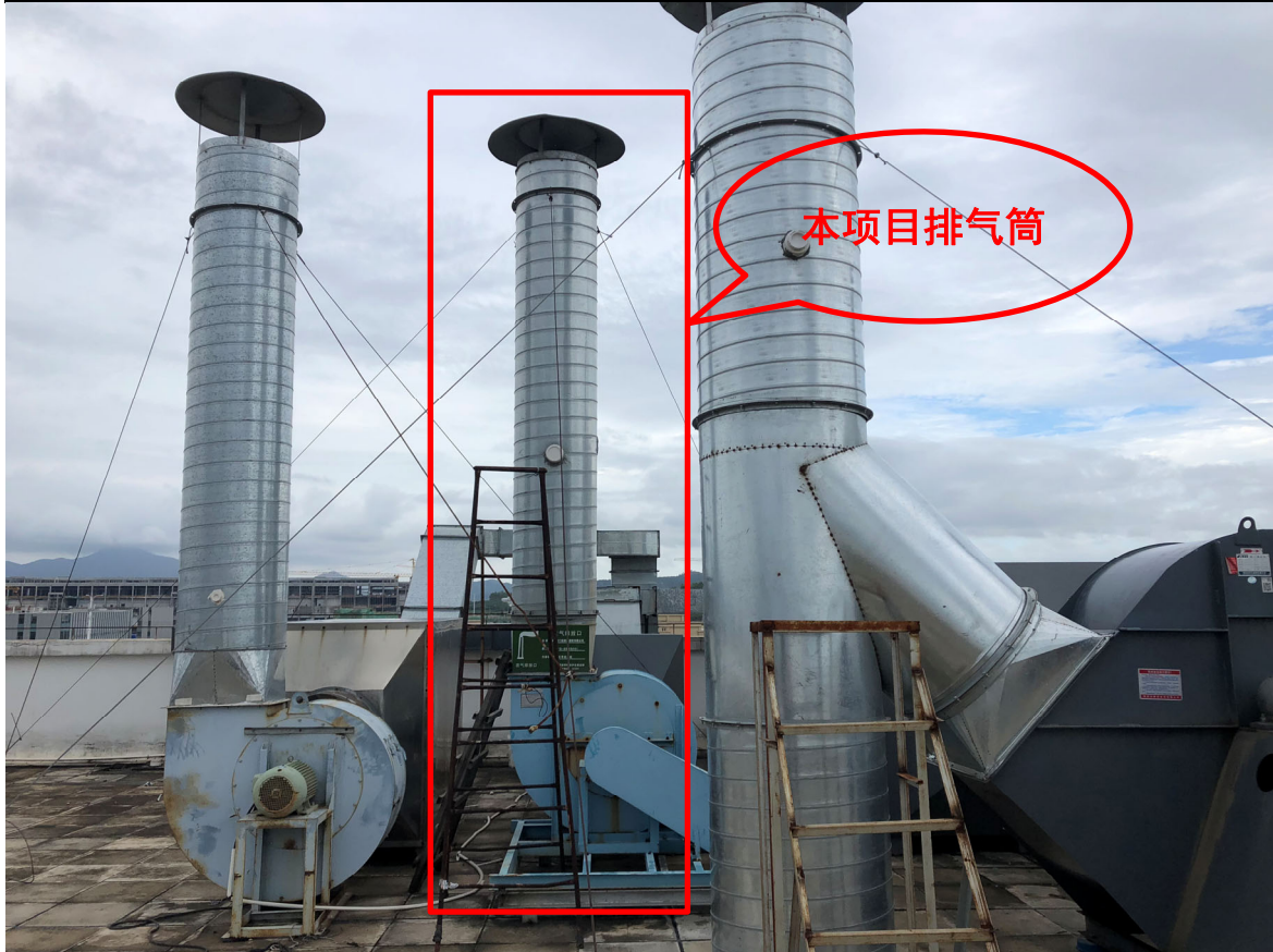
图 4-2 废气污染防治措施照片
