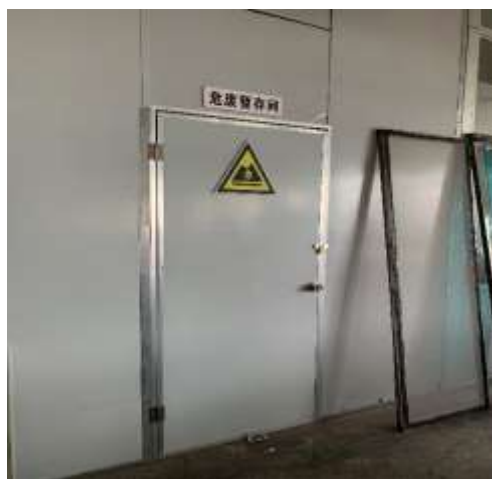
危险废物暂存间
