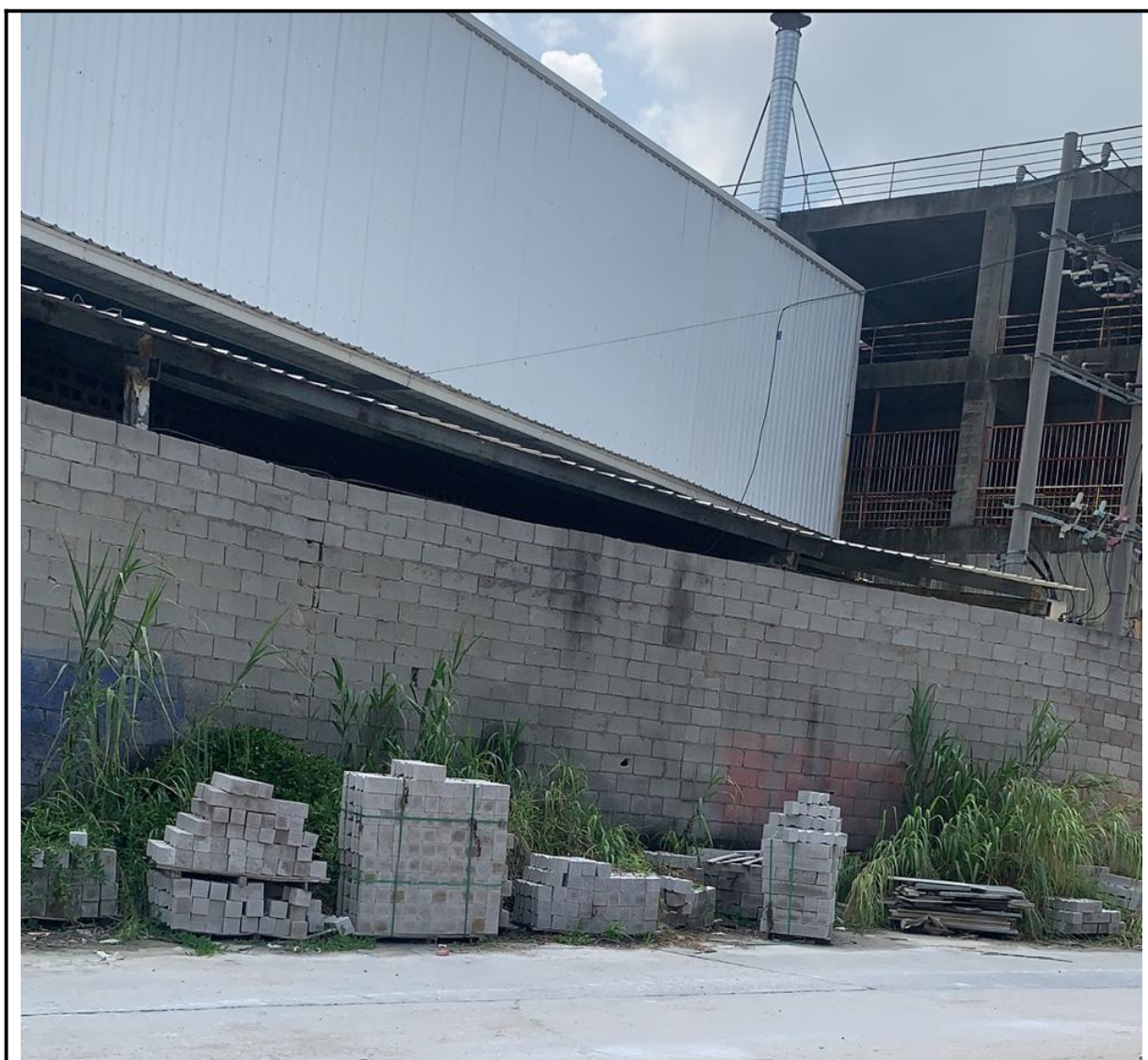
项目西侧他人厂房及居住区
