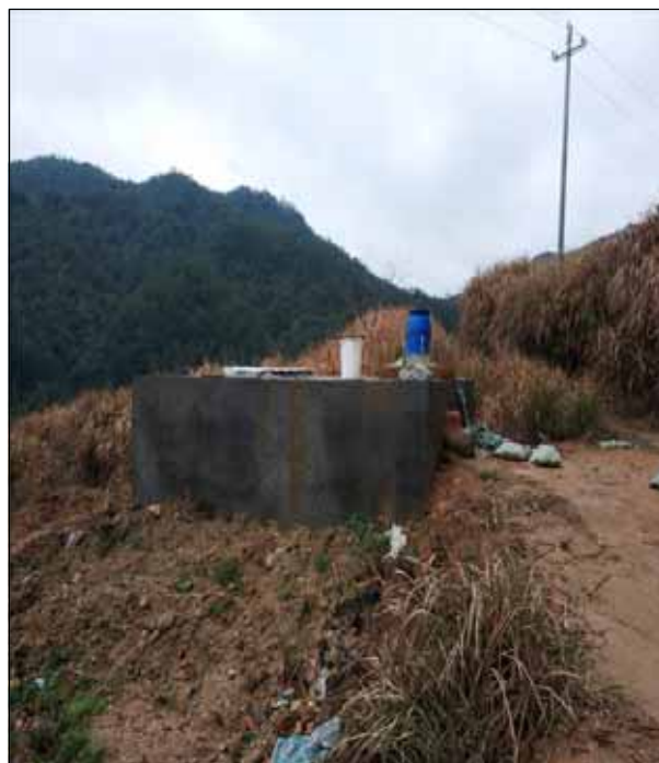
无害化处理池
