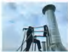
废气处理设施PI 进口
