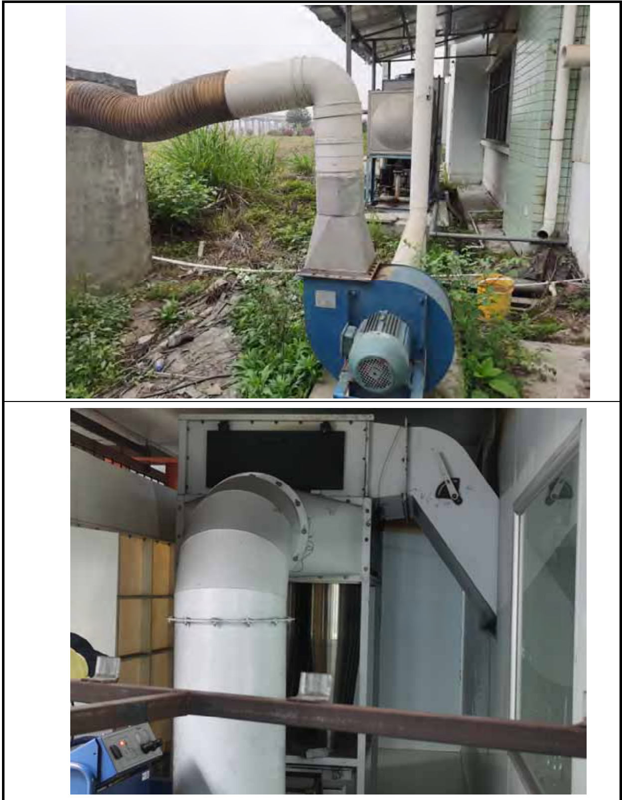
图 4-3 废气处理设施图
