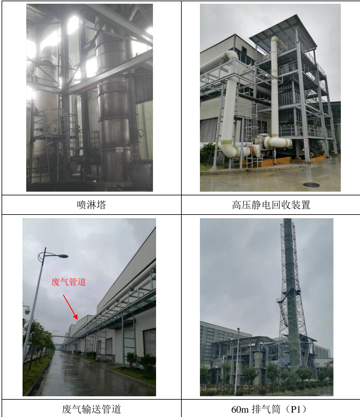
图 4.1-3 研发炭塑化、定型及炭化、活化废气治理设施现场情况
