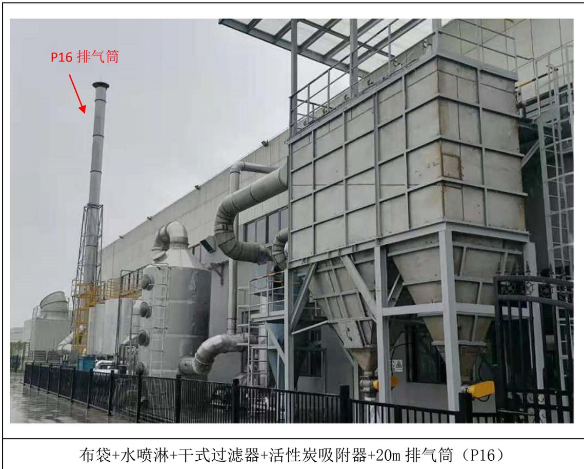
图 4.1-7 1#电容炭炭化活化废气治理设施现场情况
