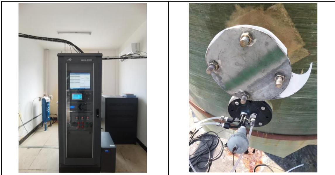
图 4.2-3 化学炭炭化活化排气筒（P1）在线监测设施现场情况
