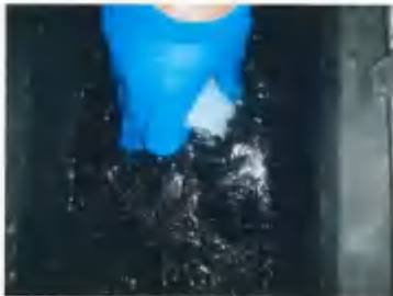
废水处理设施★进口 W01
