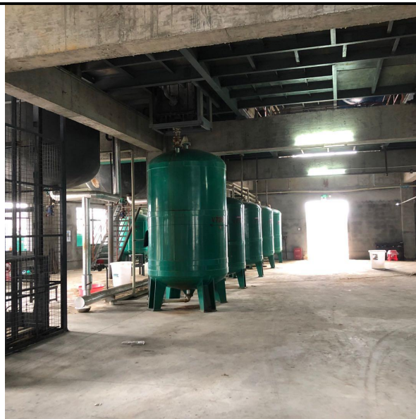
生产车间防渗
