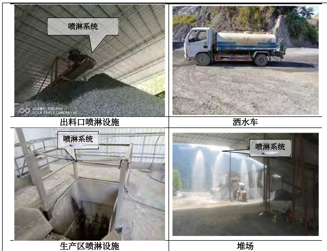
图 3-1 项目废气处理设施现场图
