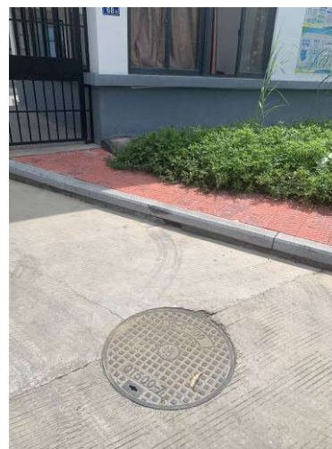
市政污水排放口
