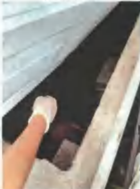
废水处理设施进口 W1
