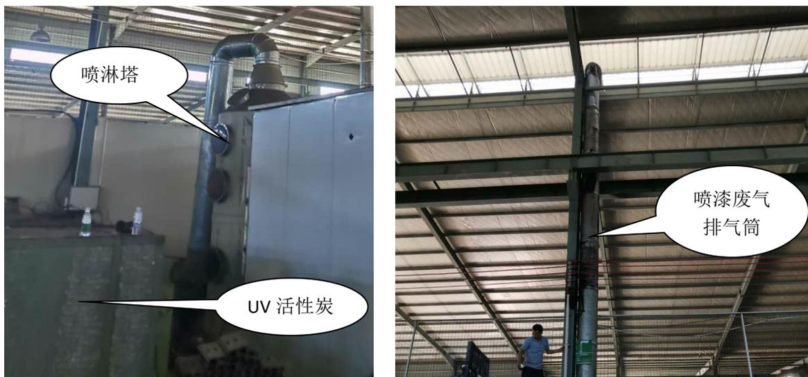
图 4-4 项目废气处理设施图
