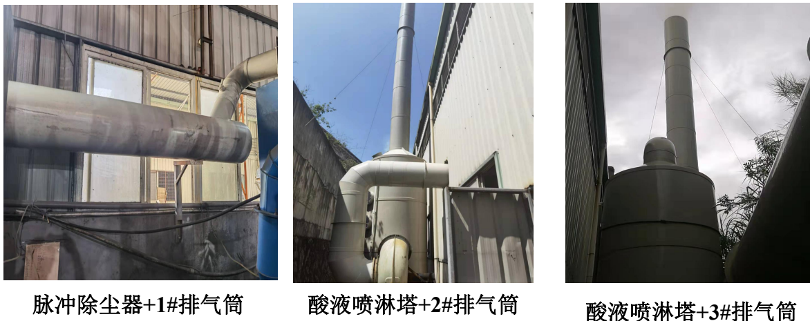
图4-3 废气处理设施图
