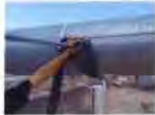
储油罐废气处理设施P1 进口
