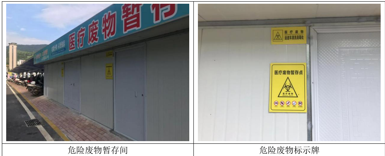
图 5-5、危险废物暂存间照片
