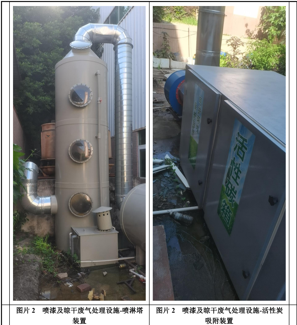
图 4-4 废气处理设施图
