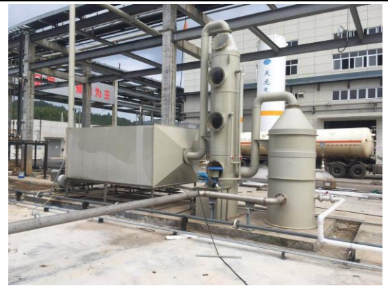
混合储罐区废气处理设施
