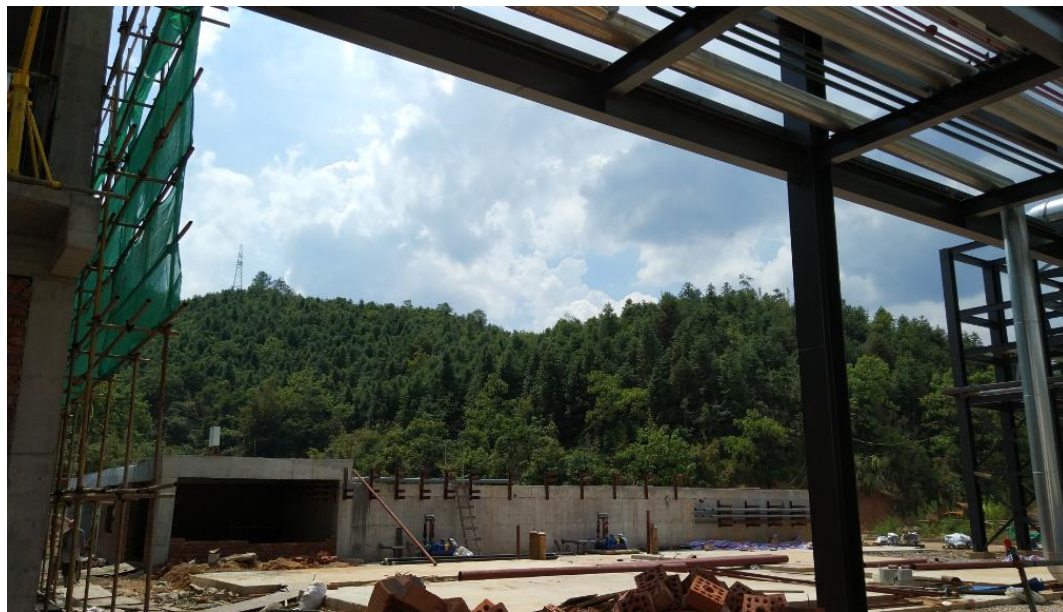
在建改造的污水处理站设施
