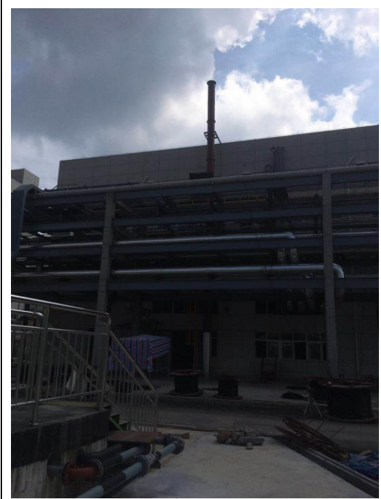
蒸汽发生器燃气废气 20 米高排气筒
