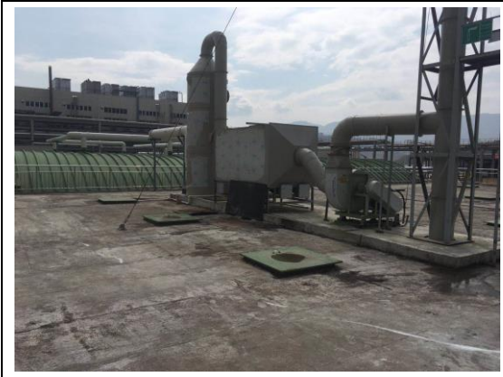
污水处理站废气处理设施
