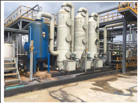
酸罐区废气处理设施
