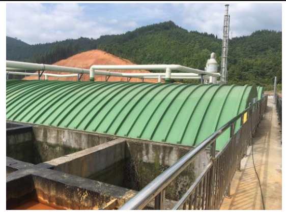
污水处理站废气处理设施
