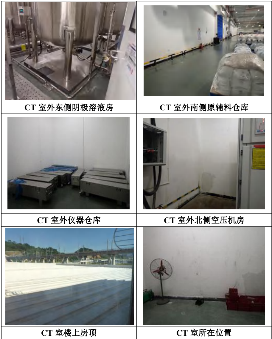
图 1.3-10 湖西 Z 基地 CT 检测室及四周照片
