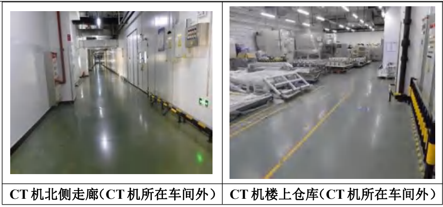
图 1.3-9 工程中心 CT 机四周照片
