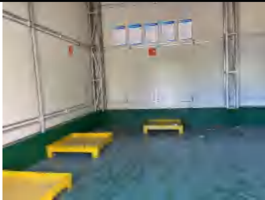
危废暂存间内部
