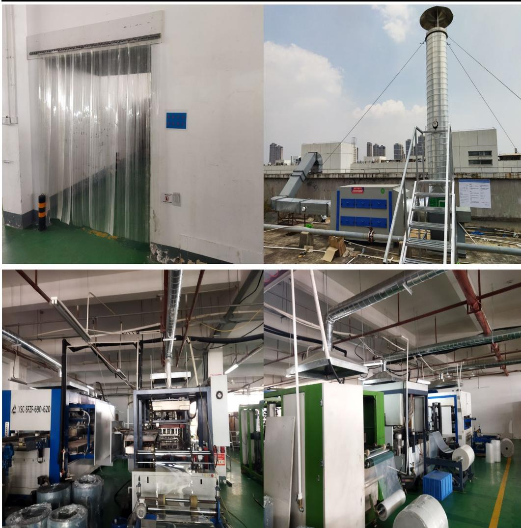
图 4-1 废气污染防治措施照片
