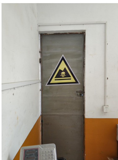
危险废物暂存间
