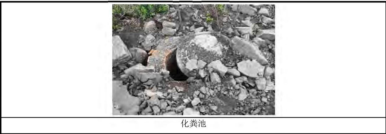
图 4-1 项目废水治理设施图
