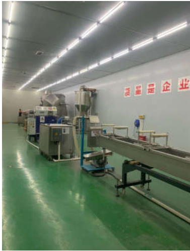
密闭生产车间现状
