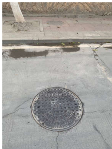
市政污水排放口
