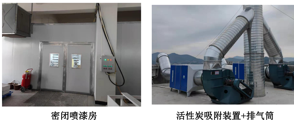
图4-3 废气处理设施图
