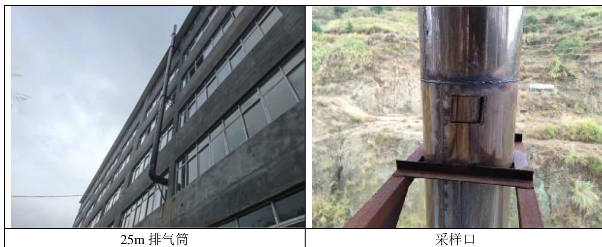
图 4-3 废气治理措施现状照片
