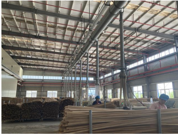
精刨工段粉尘收集管道
