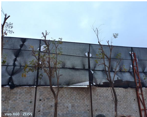
厂界喷淋设施
