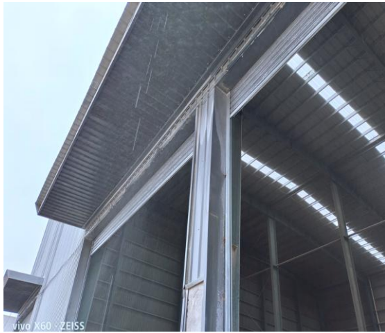
车间喷淋设施
