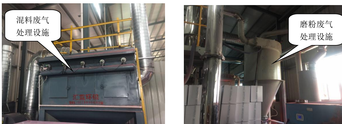
图 4-4 废气处理设施图
