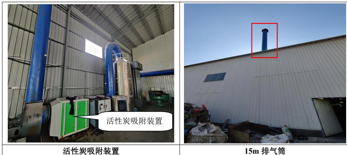
图 4-3 项目废气处理设施现场照片
