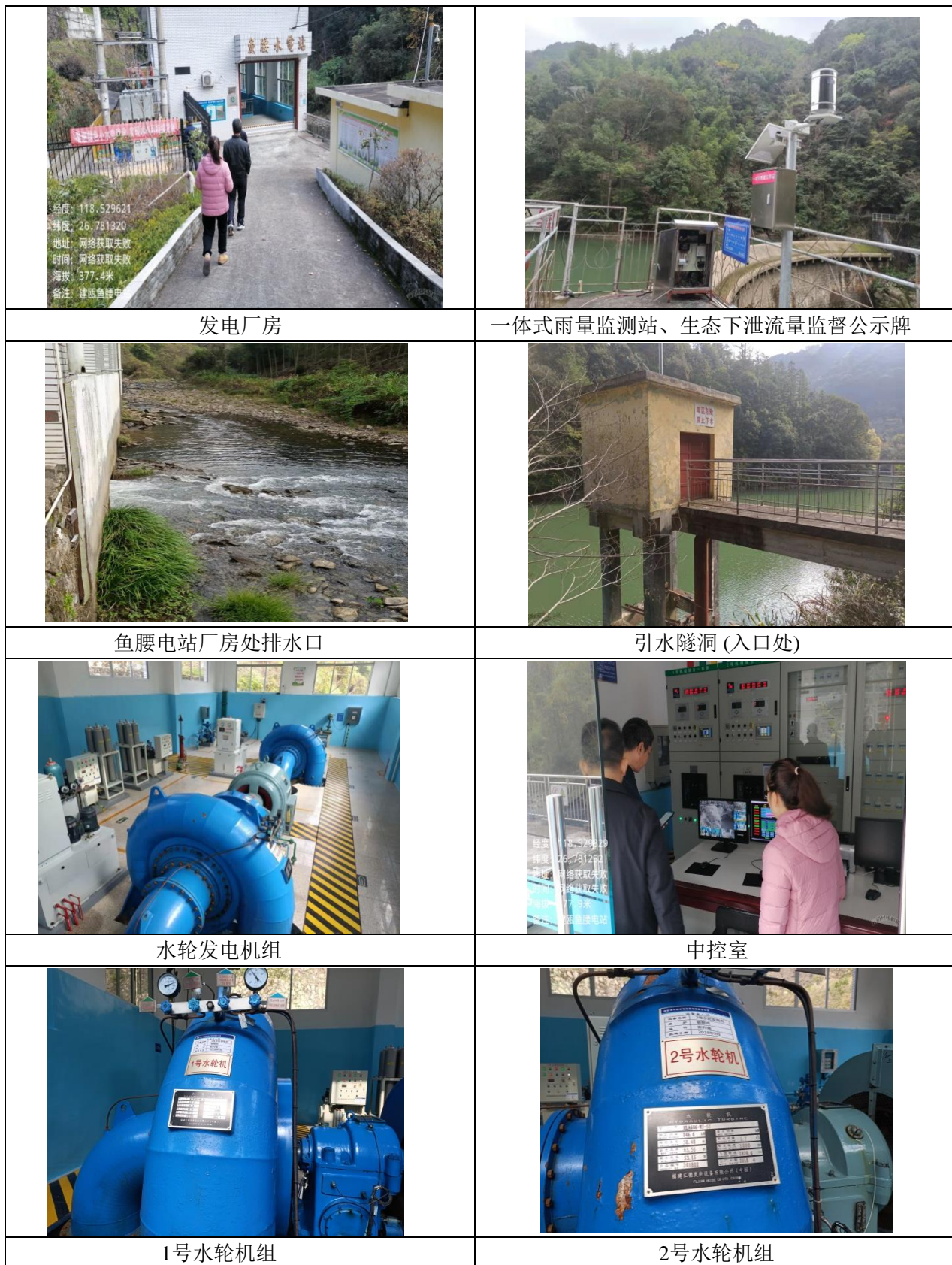
图 3.2-1 鱼腰水电站现状照片
