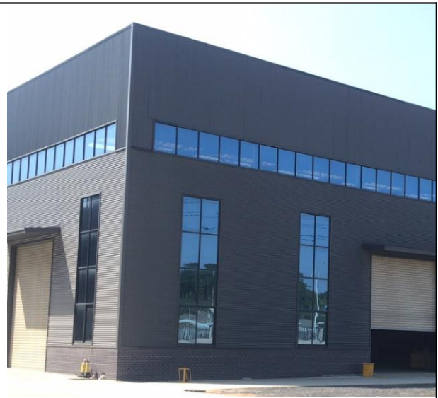
项目 2#生产车间
