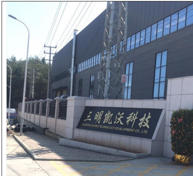
项目厂区门口及 1#车间（厂房已建）
