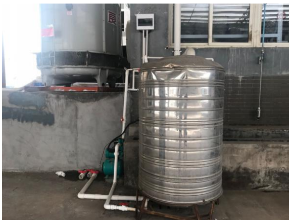
4号楼焊接蓄水池
