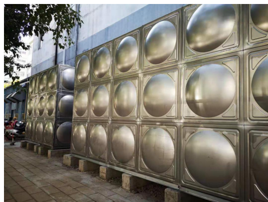
1号楼焊接蓄水池
