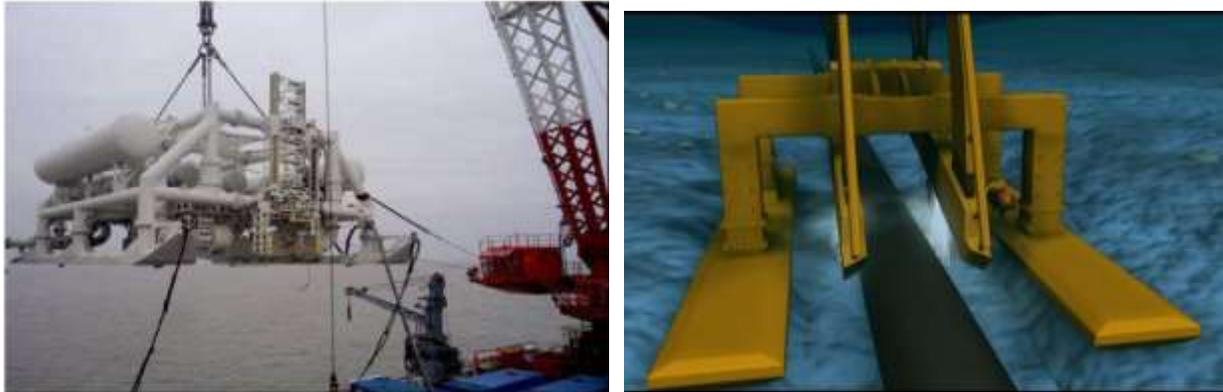
图2.3-8 后挖沟机现场作业图
