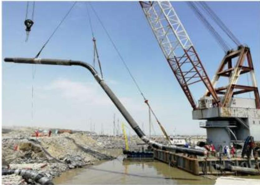
图2.3-5 斜立管吊装施工
