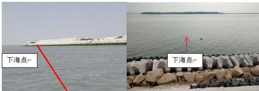
图 2.3-2 在建斜坡式结构的挡浪堤现状图
