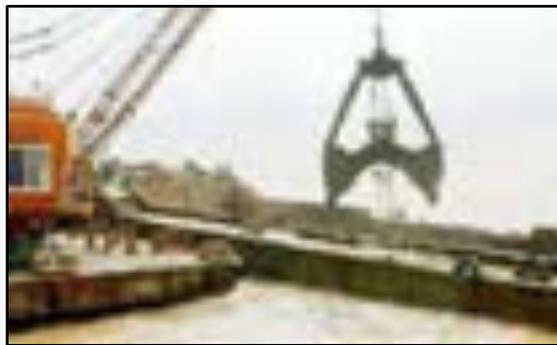
图 2.5-1 挖泥船挖泥装驳示意图
