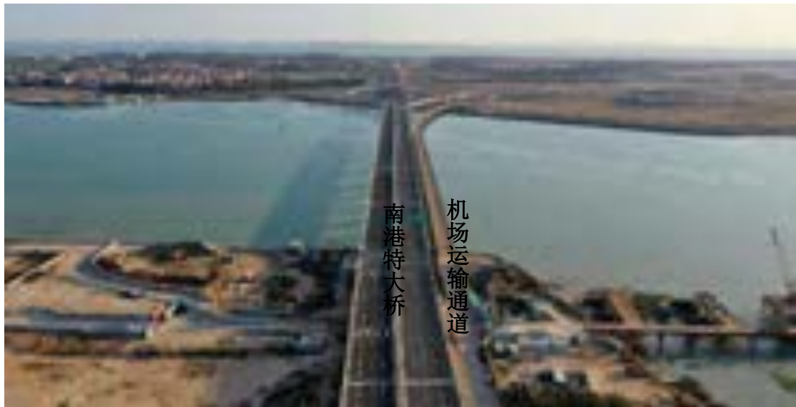
图 3.3-2 机场运输通道、南港特大桥
