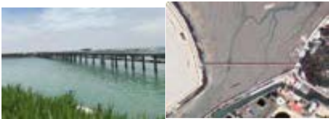
图 3.3-3 大小嶝造地工程（围堰）临时钢栈桥
