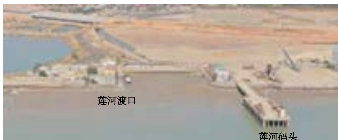
图 3.3-7 莲河码头、莲河渡口
