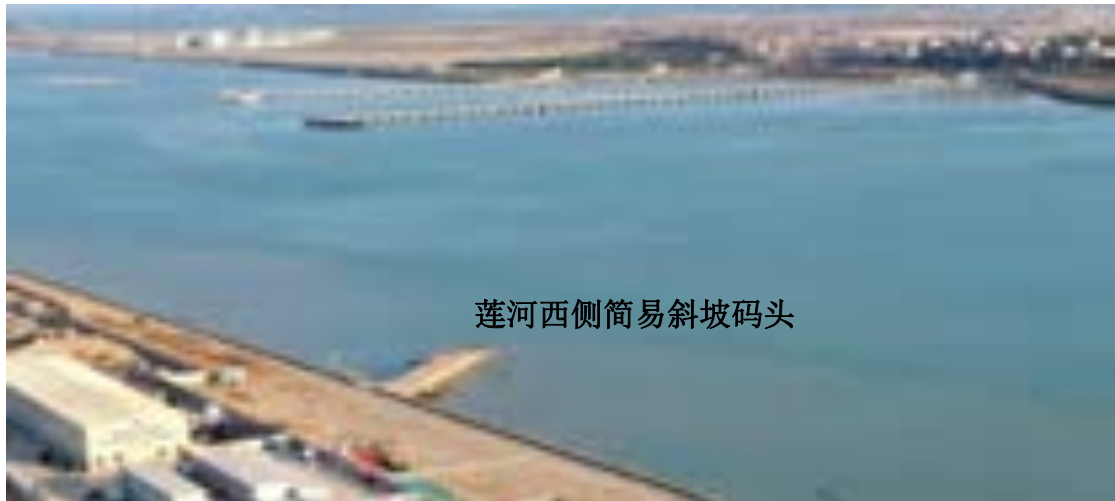
图 3.3-8 莲河西侧简易斜坡码头
